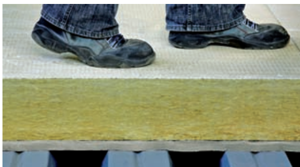
Príklad možnej nenavýšenej pochôdznej úpravy (v rovine): dosky Monrock MAX E sú v priestore so zvýšenou frekvenciou pohybu nahradené doskami Megarock MAX s cementovou vrstvou hore, rovnakej hrúbky ako okolie alebo podloženými na rovnakú hrúbku obkolesujúcej izolácie (obr. 29)
