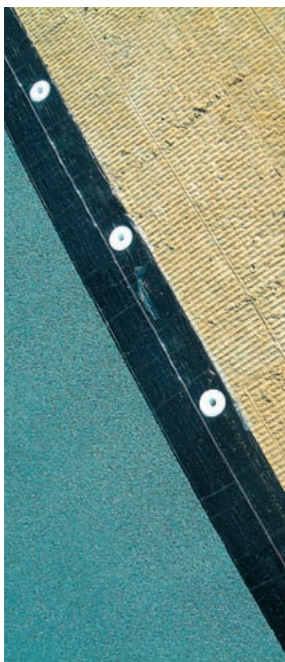
Teleskopický systém – plastový teleskop + ocelová skrutka (obr. 47 + 48)
