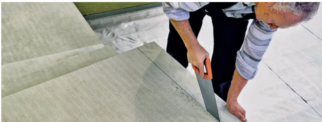
Rezanie dosiek Megarock (MAX) – ani vrchná cementová vrstvička nepredstavuje prekážky pre pílu (obr. 53)
