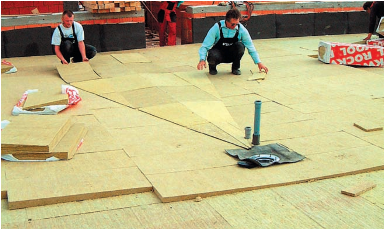
Pokládka dosiek ROCKFALL do úžlabia na spádových doskách (obr. 36)
