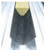
Výplň trapézového plechu akustickými klinmi a sklotextilnou separáciou (obr. 27)
