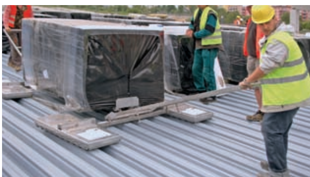
Manipulačný vozík Lift & Roller. Poloha po nadvihnutí palety – vozík pripravený na presun (obr. 54)
