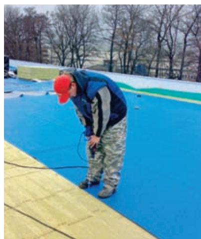
Kotvenie povlakovej hydroizolácie (obr. 10)
