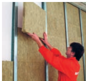
Najvhodnejším materiálom na izoláciu je Airrock ND (obr. 18)
