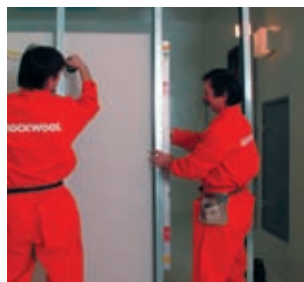
Montáž kovových nosných profilov (obr. 16)
