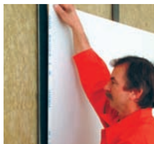
Montáž sadrokartónových dosiek (obr. 20)
