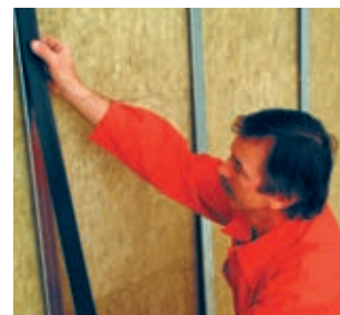
Lepenie separačnej samolepiacej PE pásky na kovové profily (obr. 19)
