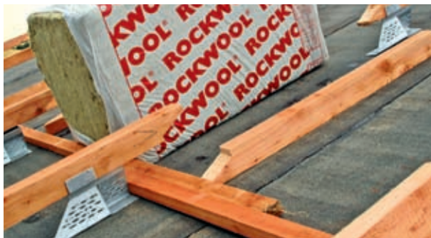
Ukladanie izolácie pri systéme TOPROCK (obr. 18)
