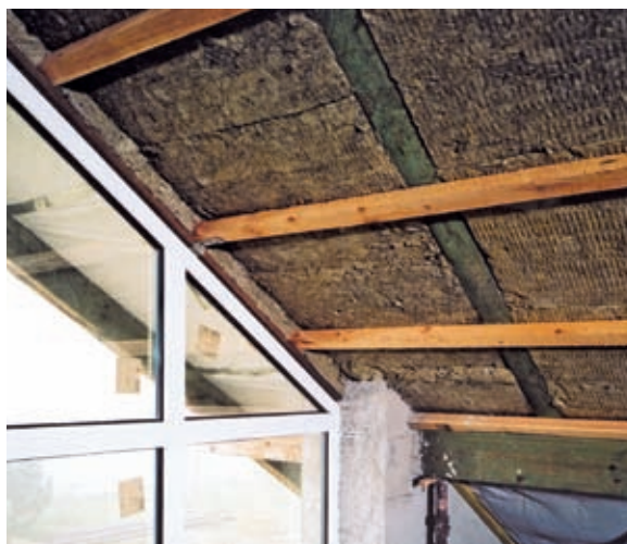
Prevedenie zateplenia medzi krokvy (obr. 4)
