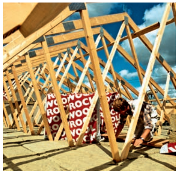
Konštrukcia so zateplným stropom (obr. 12)
