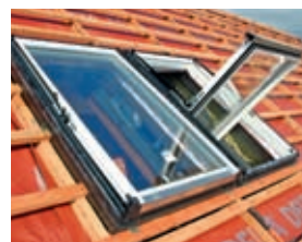
Montáž strešného okna (obr. 22)
