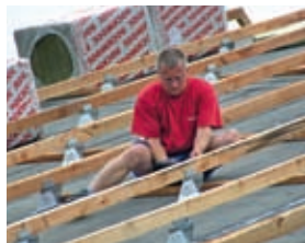
Vloženie prídavnej krokvy do kovového držiaka (obr. 21)
