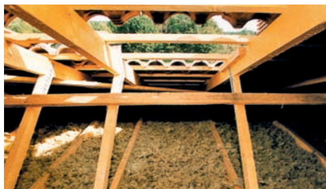
Väzniková strecha – izolácia stropu (obr. 15)
