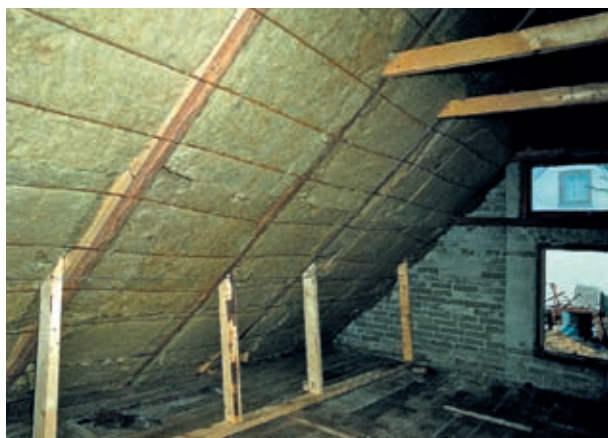
Ešte zostáva doplniť izoláciu pod krokvami (obr. 13)
