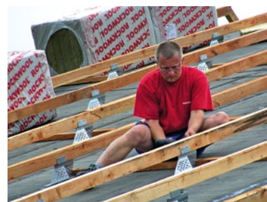
Vložení přídatné krokve do kovového držáku (obr. 21)
