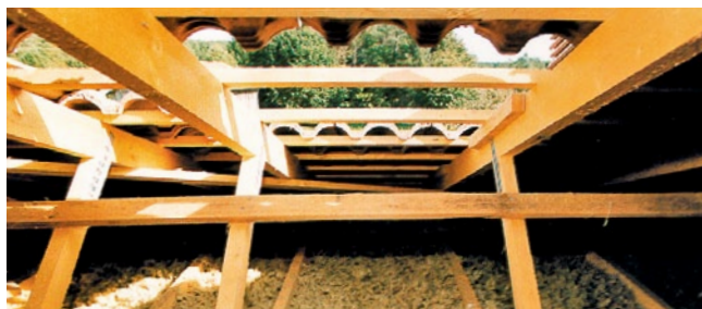
Vazníková střecha – izolace stropu (obr. 15)
