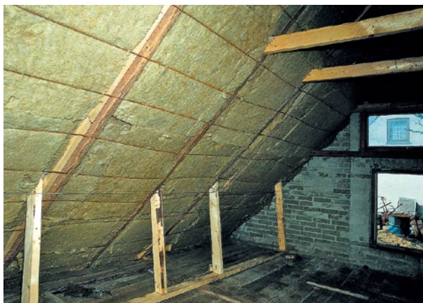
Ještě zbývá doplnit izolaci pod krokve (obr. 13)
