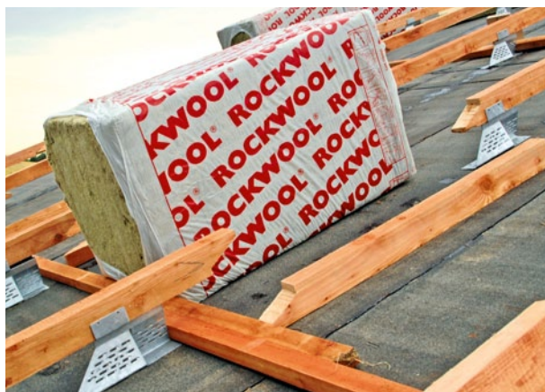
Pokládka izolace u systému TOPROCK (obr. 18)
