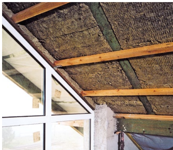
Provádění zateplení mezi krokvemi (obr. 4)
