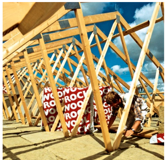
Konstrukce se zateplným stropem (obr. 12)
