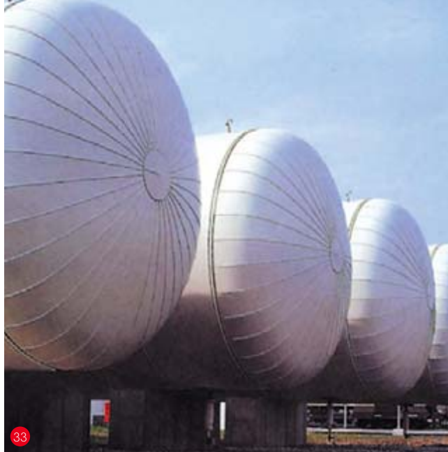
Zásobníky izolované rohožemi na drátěném pletivu
