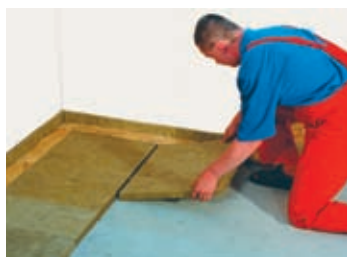
Položenie izolácie Steprock HD (obr. 17)
