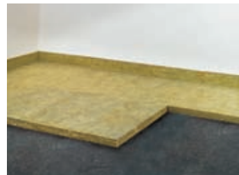
Kladenie dosiek Steprock ND (obr. 4)
