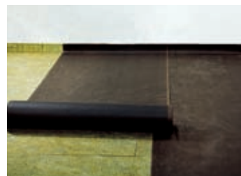
Kladenie hydroizolačnej vrstvy (obr. 5)
