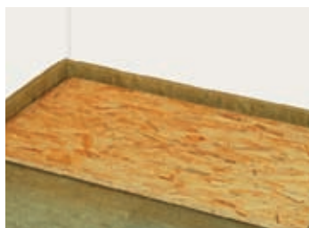
Okrajový pásik Steprock a prvá roznášacia vrstva (obr. 18)
