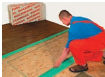
Položenie druhej roznášacej vrstvy (obr. 19)
