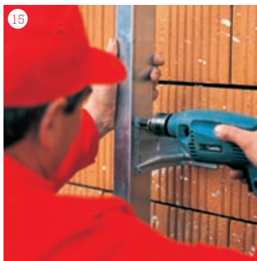
3. Montáž nosných profilov pre obklad
