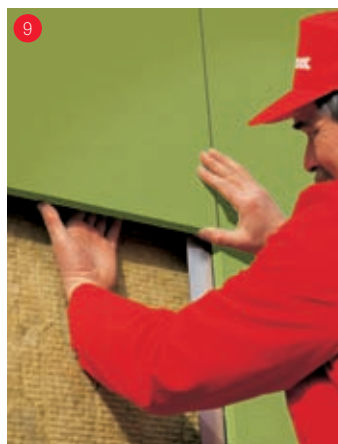
Prevetrávaný zateplovací systém
