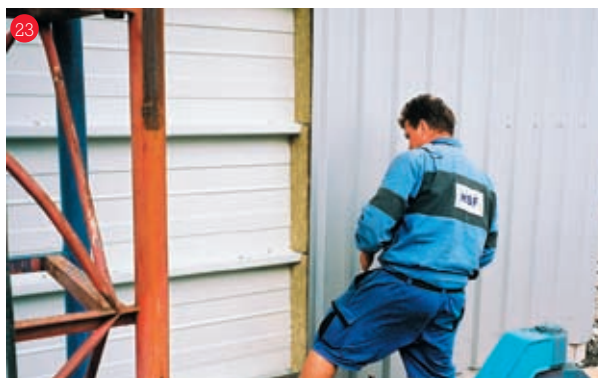
Vyrovnávanie obkladového trapézového plechu na sokli stavby
