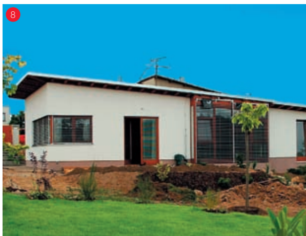
Fasáda zateplená kontaktným systémom
