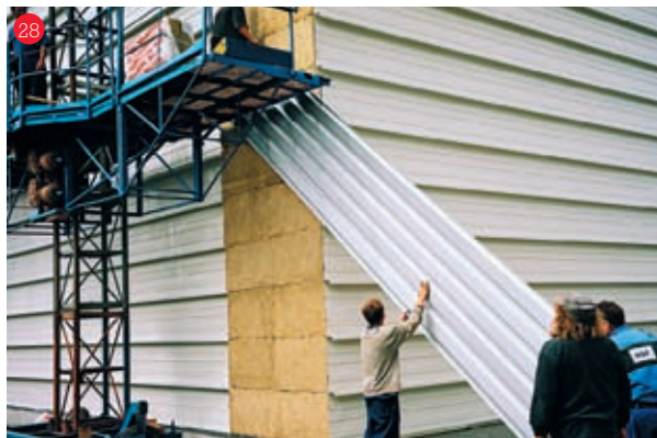
Presun obkladového plechu na fasádu
