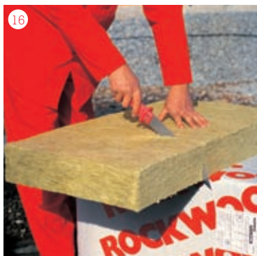
4. Rezanie izolácie – izoláciu je možné rezať špeciálnym nožom, prípadne nožom so zubmi
