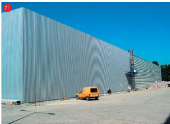
Kompletace kazetového systému ROCKPROFIL – celkový pohľad
