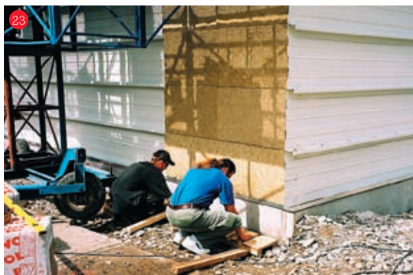
Po vložení izolačných dosiek Airrock ND (pre ROCKPROFIL) sa pripravuje montáž obkladového plechu
