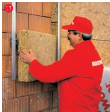
5. Vkladanie izolácie medzi nosné profily fasády
