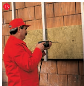
6. Vŕtanie otvorov pre tanierové hmoždinky, slúžiace na uchytenie tepelnej izolácie
