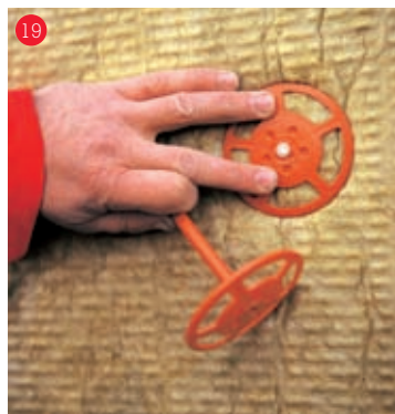
7. Kotvenie izolácie pomocou držiakov izolácie DH
