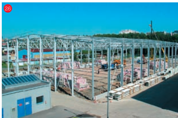
Montáž skeletu stavby
