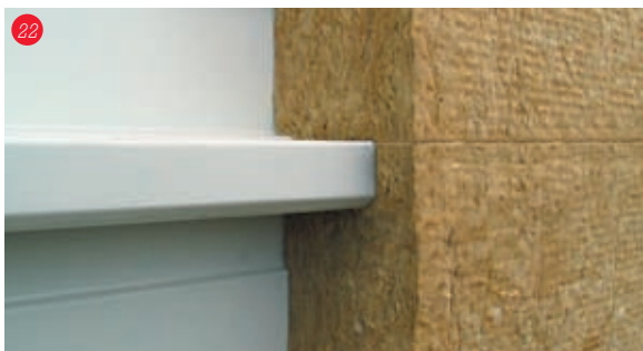
Izolačná doska Airrock ND presahuje kazety o 40 mm
