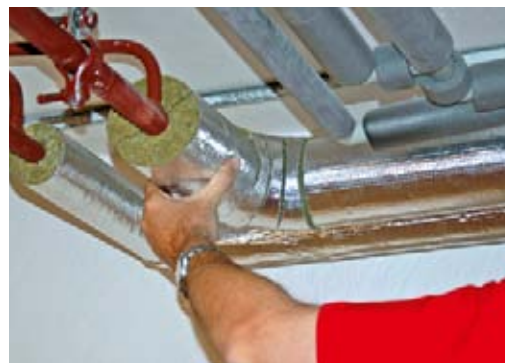
Izolácia rozvodov centrálného kúrenia potrubným puzdrom PIPO ALS
