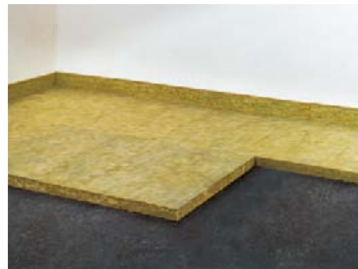
Pokládka dosiek Steprock ND a dilatačného pásu
