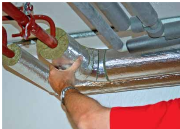
Központi fűtés csöveinek hőszigetelése PIPO ALS csőburkolattal
