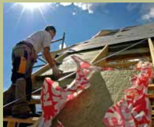
Rockwool hőszigetelés szarufák felett
