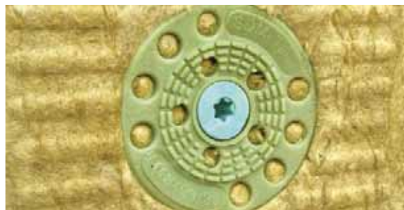
Ukázka správně zapuštěné hmoždinky (obr. 30)
