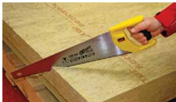
Řezání fasádních desek speciální pilkou (obr. 26)
