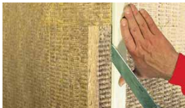
Odstranění přebytečné izolace v rohu (obr. 25)
