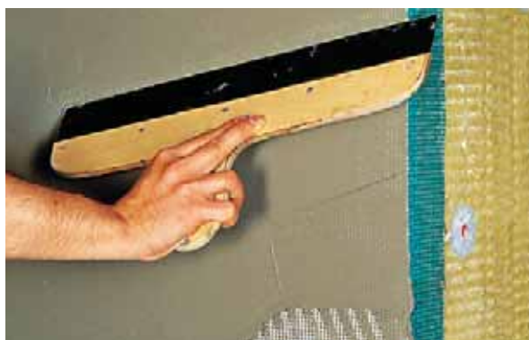
Vyhlazení krycí hmoty po aplikaci výztužné síťoviny (obr. 35)
