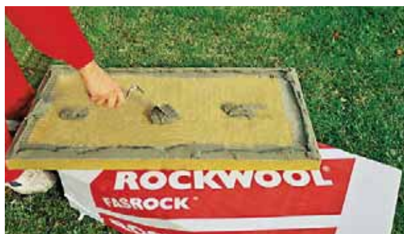
Nanášení terčů a válečků (obr. 15)
