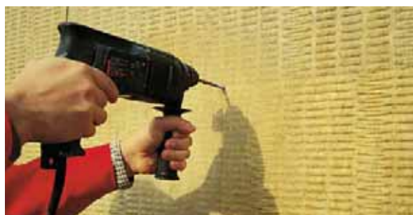
Vrtání otvoru pro hmoždinku (obr. 28)
