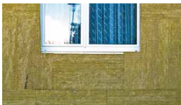
Správné osazení desek u otvorů (obr. 18)
