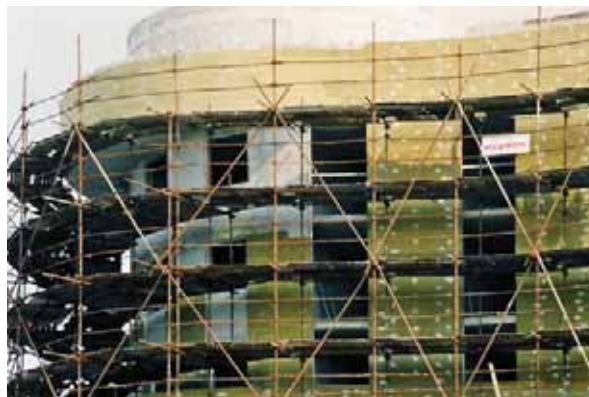
Aplikace Fasrock LL na oblou stěnu (obr. 41)
