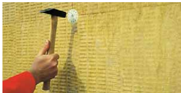
Upevnění talířové hmoždinky (obr. 29)
