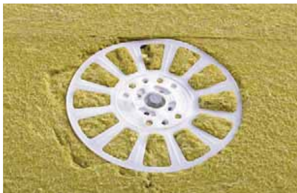
Ukotvení lamel Fasrock LL talířovou hmoždinkou (obr. 33)
