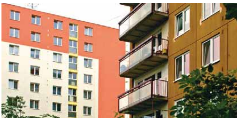
Zateplený panelový dům (vlevo) a nezateplený panelový dům (obr. 3a)
