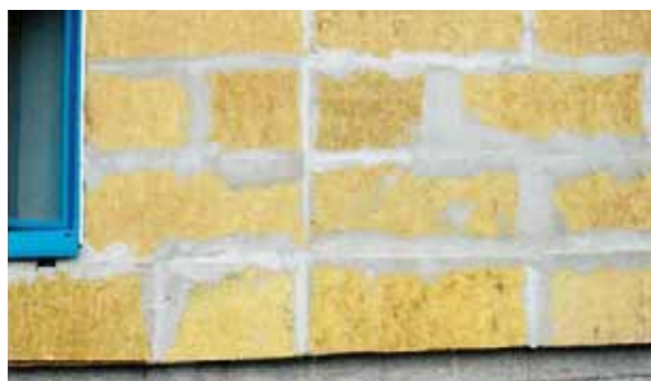
Nevhodné „vyplňování“ spár lepidlem (obr. 21)
