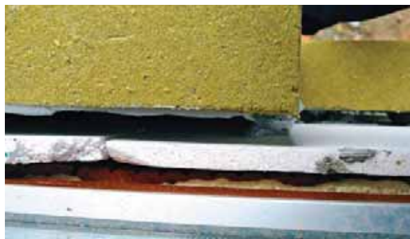
Nevhodná aplikace desek – zakázané tzv. podlepování (obr. 17)
