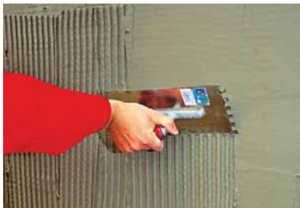
Nanášení stěrkové hmoty pro aplikaci výztužné síťoviny (obr. 32)
