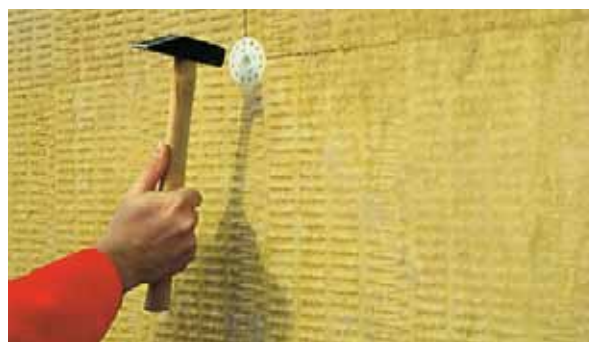
Upevnenie tanierovej kotvy – natlákacej (obr. 29)
