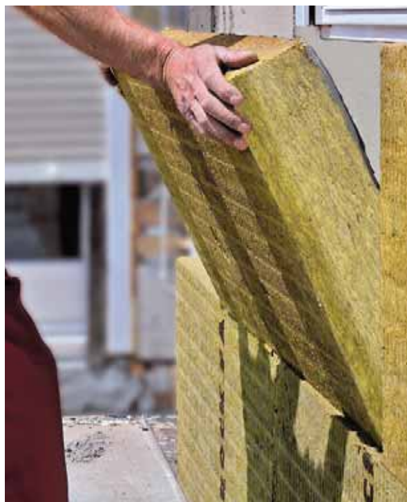
Montáž ETICS s doskami Frontrock MAX E (obr. 36)
