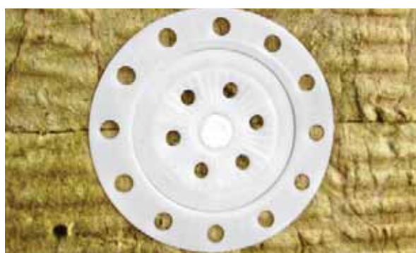
Správne osadená mechanická kotva s termoizolačnou zátkou. Tanierik licuje s povrchom dosky Frontrock MAX E (obr. 38)
