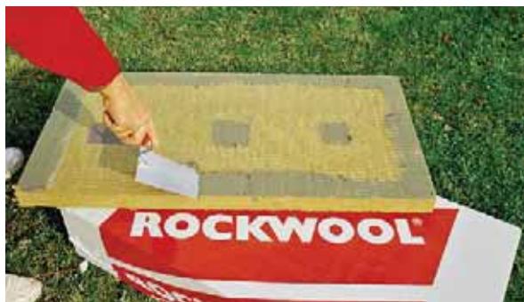
Ľahké prestierkovanie dosky v mieste aplikácie lepidla (obr. 14)
