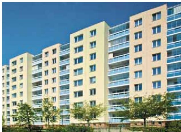
Príklady fasád zateplených pomocou dosiek ROCKWOOL (obr. 9, 10)
