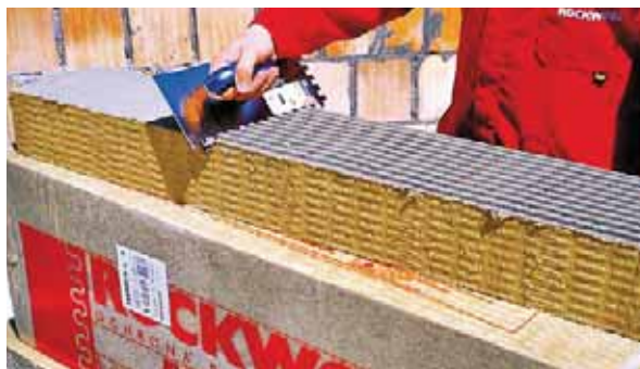
Nanášanie lepiacej hmoty u dosiek Fasrock LL (obr. 13)
