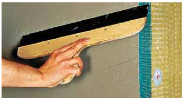
Vyhľadanie stierkovej hmoty po aplikácii výstužnej sieťoviny (obr. 34)
