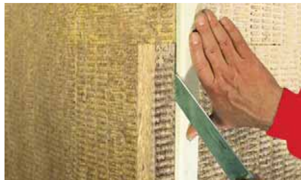
Odstránenie prebytočnej izolácie v rohu (obr. 25)
