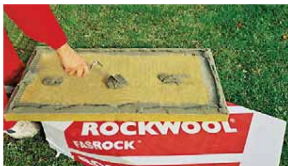
Nanášanie rámika a terčov (obr. 15)
