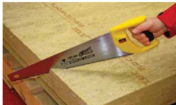
Rezanie fasádnych dosiek špeciálnou pílkou (obr. 26)
