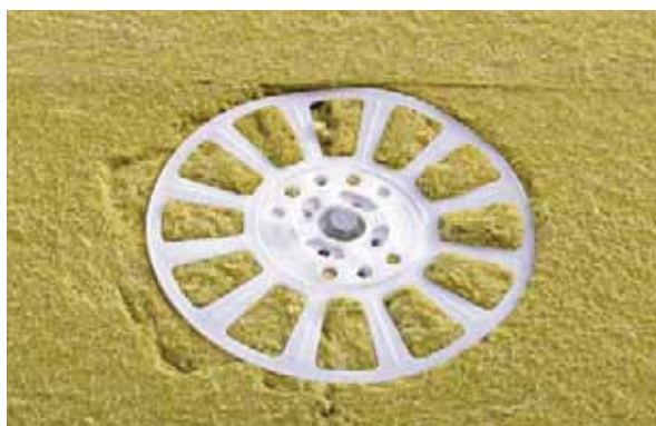
Ukotvenie lamiel Fasrock LL tanierovou kotvou (obr. 33)
