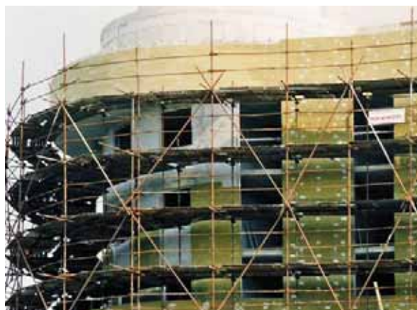
Aplikácia Fasrock LL na oblú stenu (obr. 40)
