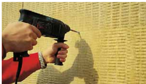
Vítanie otvoru pre kotvy (obr. 28)
