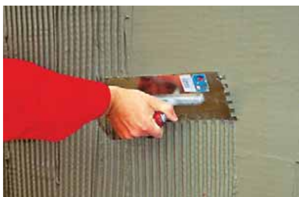
Nanášanie stierkovej hmoty pre aplikáciu výstužnej sieťoviny (obr. 32)
