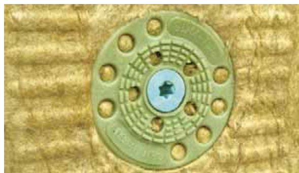
Ukážka správne zapustenej kotvy (obr. 30)
