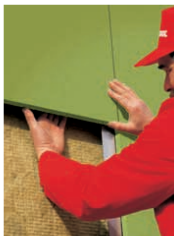
Provětrávaný zateplovací systém (obr. 10)
