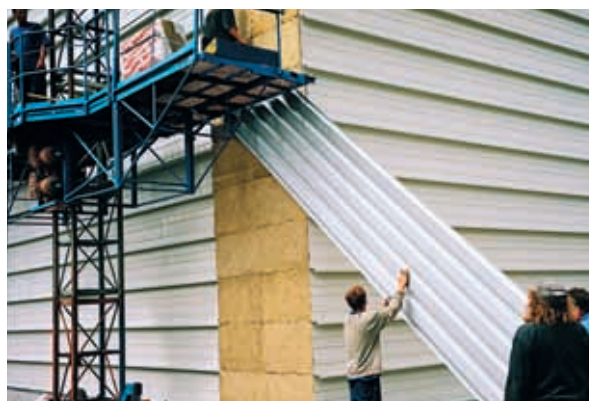
Přesun obkladového plechu na fasádu (obr. 28)
