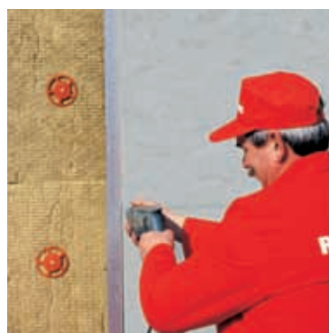
8. Montáž obkladu fasády (obr. 21)
