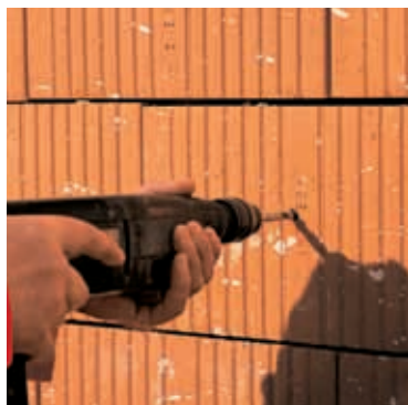
1. Vrtání otvorů pro hmoždinky kotev (obr. 14)
