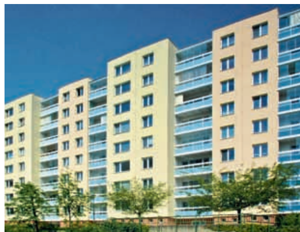
Fasáda zateplená kontaktním systémem (obr. 9)
