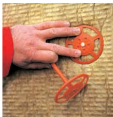
7. Kotvení izolace pomocí např. držáků izolace (obr. 20)
