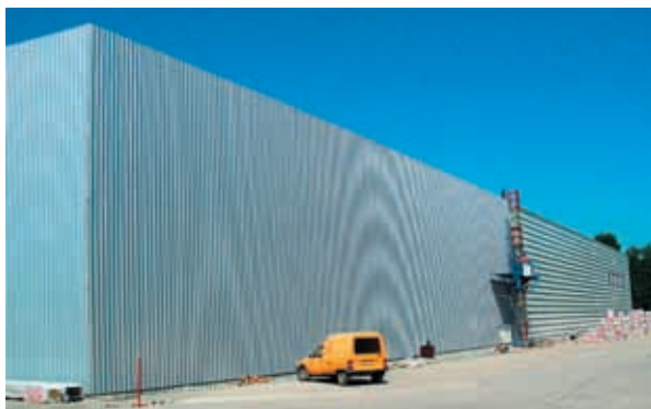
Kompletace kazetového systému ROCKPROFIL – celkový pohled (obr. 22)
