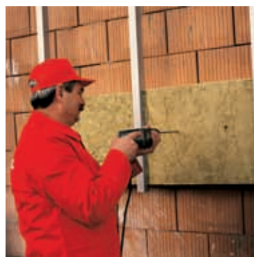
6. Vrtání otvoru pro talířové hmoždinky, sloužící k uchycení tepelné izolace (obr. 19)
