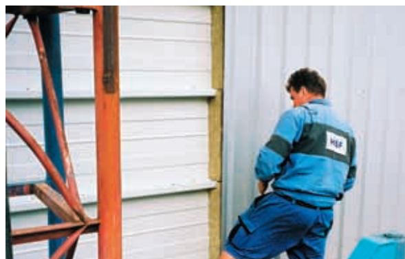
Vyrovňování obkladového trapézového plechu na soklu stavby (obr. 24)
