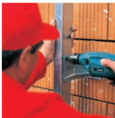
3. Montáž nosných profilů pro obklad (obr. 16)
