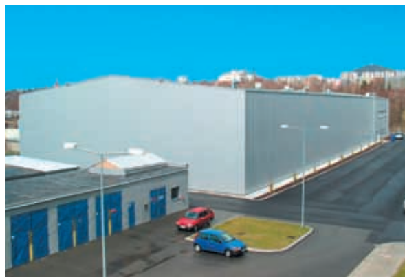
Ukončení montáže – hotový plášť haly (obr. 29)
