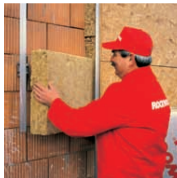
5. Vkládání izolace mezi nosné profily fasády (obr. 18)
