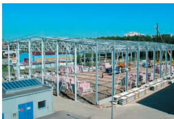
Montáž skeletu stavby (obr. 26)
