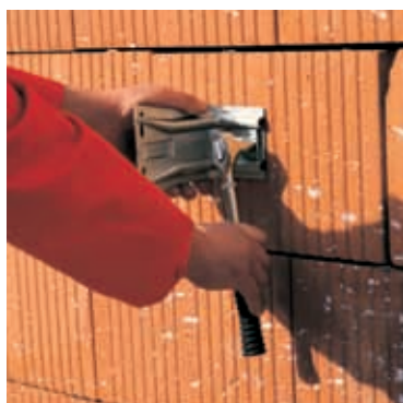
2. Montáž kotev nosných profilů fasádního obkladu (s termopodložkami) (obr. 15)
