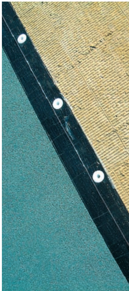
Teleskopický systém – plastový teleskop + ocelový šroub (obr. 47 + 48)
