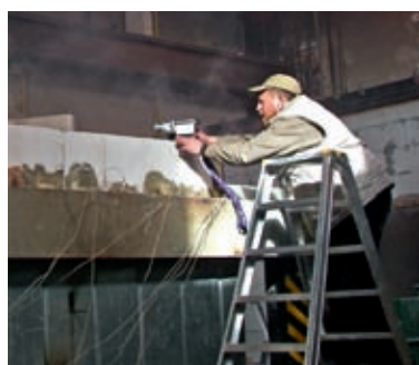
Test střechy s nehořlavou izolací Rockwool. (obr. 26)
