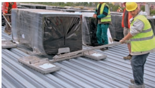
Manipulační vozík Lift & Roller. Poloha po nadzvednutí palety – vozík připraven k přesunu (obr. 54)
