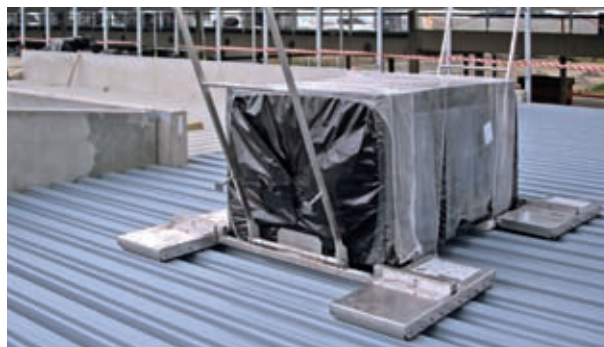
Manipulační vozík Lift & Roller. Lehký rozložitelný vozík pro transport palet s izolací po střeše. Poloha před zdvižením palety (obr. 55)
