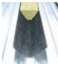
Výplň trapézového plechu akustickými klíny a sklotextilní separací (obr. 27)
