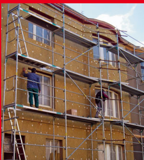
Zatepľovanie fasády materiálom Frontrock MAX E
