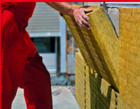
Postup montáže je podobný ako pri ostatných bežných systémoch minerálneho zateplenia ETICS
